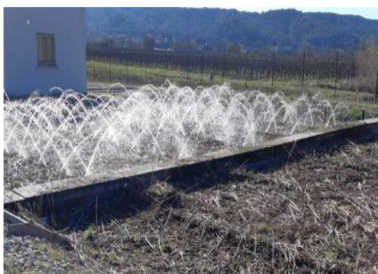
Photo de la STEU de Moulézan - A gauche, point unique de diffusion et à droite répartition uniforme
