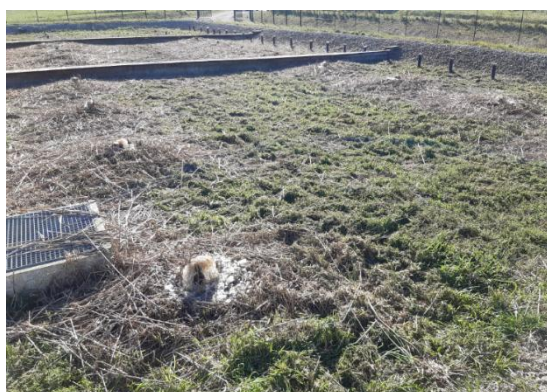
Photo de la STEU de Moulézan - A gauche, point unique de diffusion et à droite répartition uniforme
